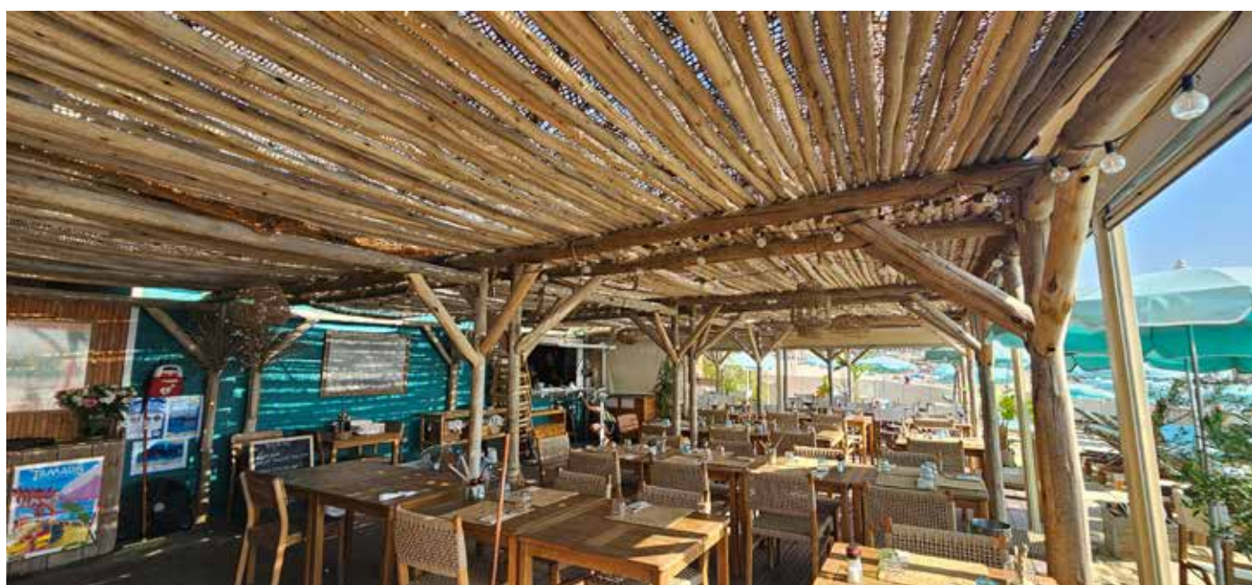
Lapas 3 x 3 m jumelés pose serrée
