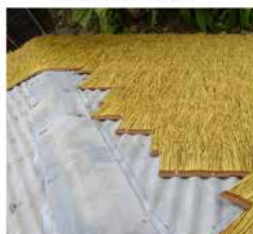
Vissage sur tôle ondulée
