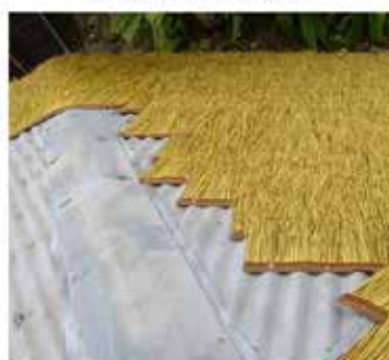
Vissage sur tôle ondulée
